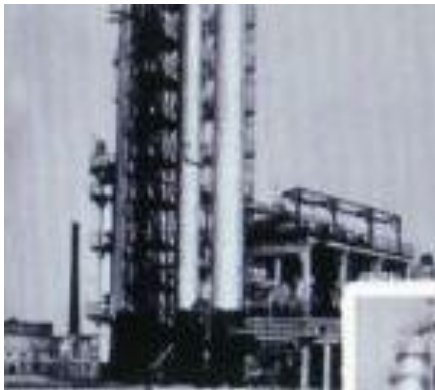
Тузсизлантирувчи электр (ТЭ) қурилмаси АВТ-1
