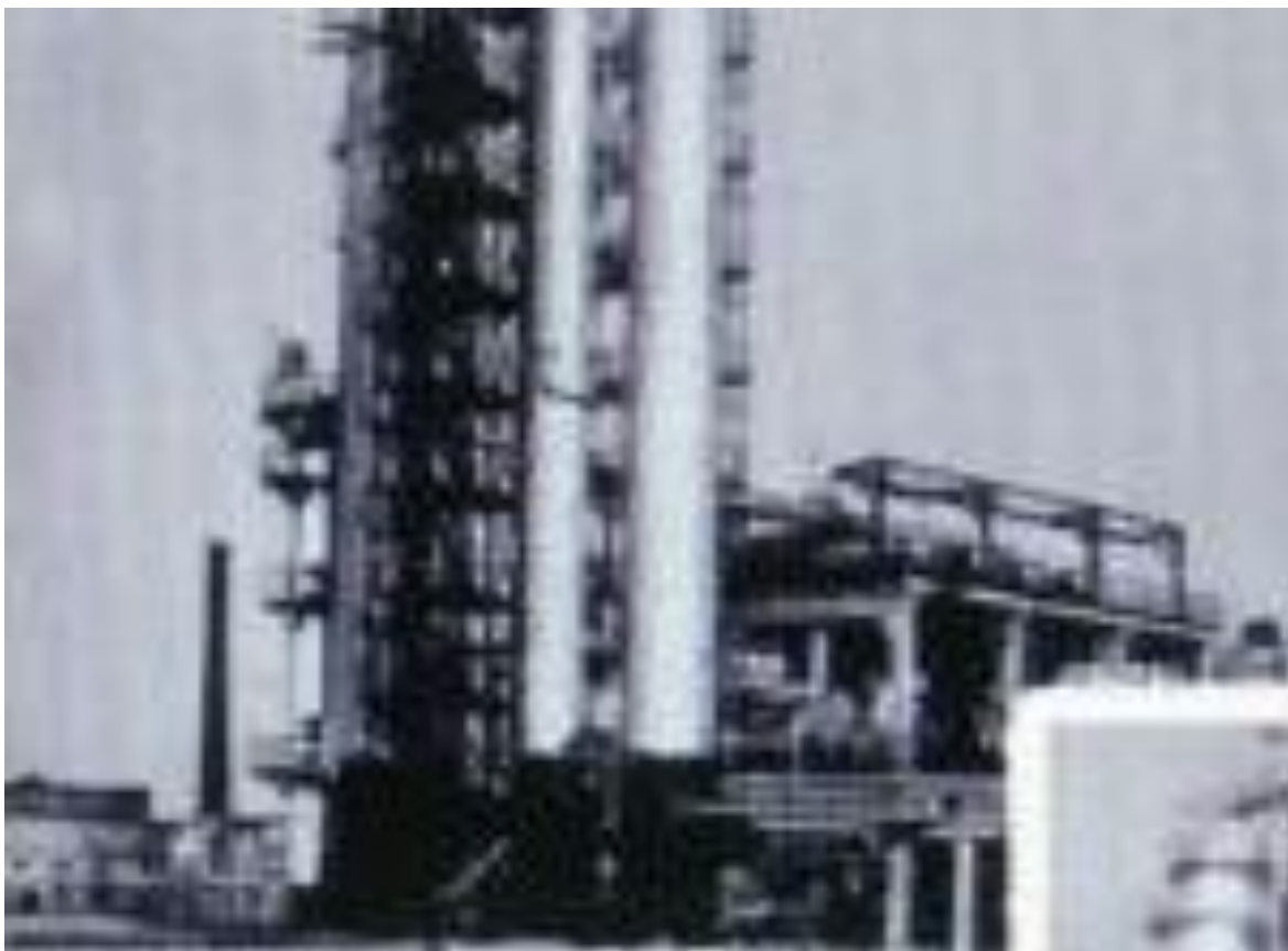
Нефтни бирламчи қайта ишловчи қурилма ЭлТҚ-АВТ-1
